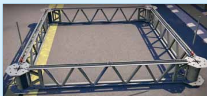
Figuur 1. De eerste module wordt op de grond opgebouwd en daarna op de gewenste plaats gehesen.
