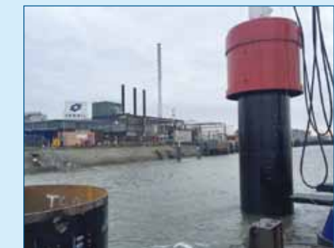
Figuur 3. Twee grote buizen moesten in Rotterdam vlak langs dienstleidingen in de bodem van een kanaal komen. Goed te zien is dat het hier om een EX-gebied gaat.
